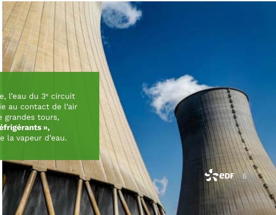
En bord de rivière, l'eau du 3<sup>e</sup> circuit peut être refroidie au contact de l'air circulant dans de grandes tours, appelées « **aéroréfrigérants** », d'où s'échappe de la vapeur d'eau.
